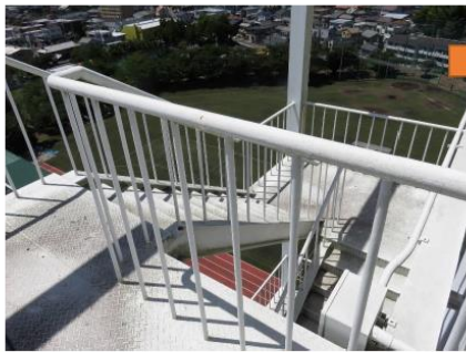
写真① 屋外非常階段（本館西）
