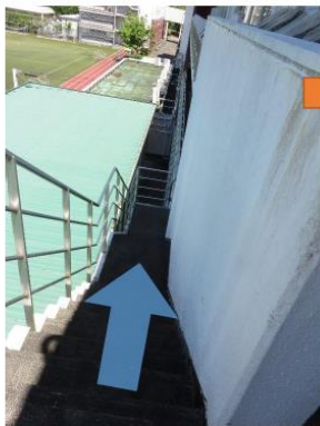
写真③ 非常階段（1号館）
