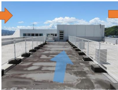
写真② 非常階段入口（自動ドア）※本館4階屋上
